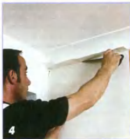
4 Под потолком размечают линию сгиба.
