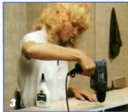
При креплении полочек шурупы ввертывают с тыльной стороны стенки.
